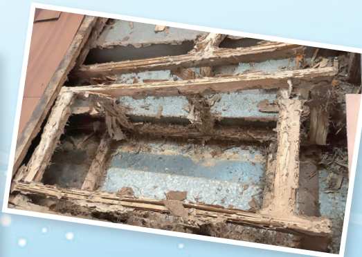
▲淡水堂除了地基下陷外，管線老舊，遇雨必漏水，祭台下白蟻蛀蝕嚴重。
